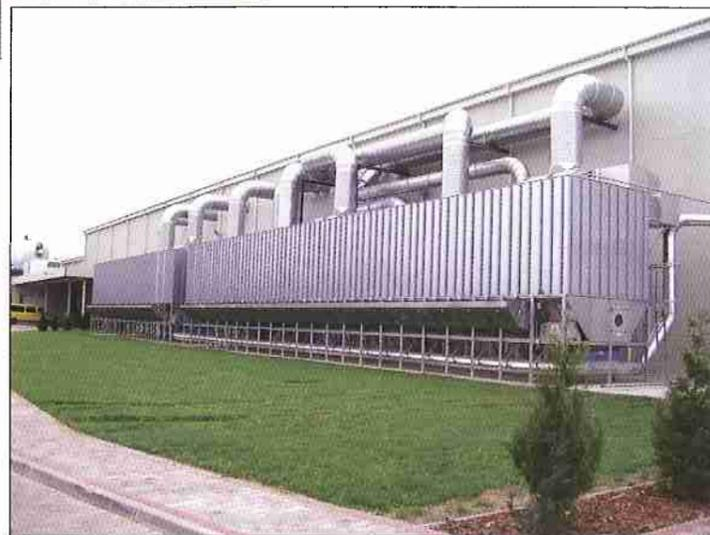
Filteranlage für Möbelfabrik in Polen mit Patentangemeldete Explosionsklappen montiert auf der Staubseite im Bodentrichter.
