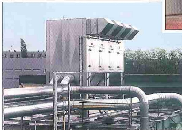
Filteranlage für 240.000 m³/h für Fensterfabrik in Schottland mit Siloanlage für Aufbewahrung der Späne vor Verbrennung.
