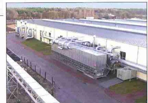
Filter Typ AKF beim Velfac's Fensterfabrik in Polen - Luftmenge 100.000 m<sup>3</sup>/h.
