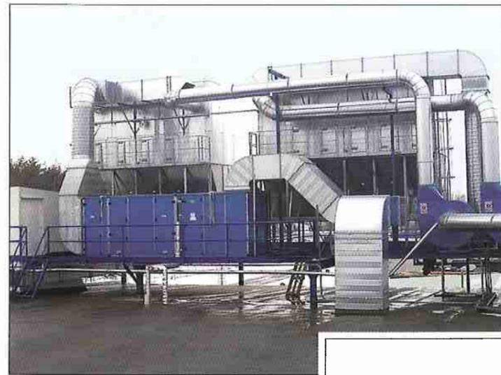
Filteranlagen in Modulbauweise Typ AKF-WDHK und AMX sind für große Luft- und Spannmengen berechnet. Die Filter sind sehr betriebssicher und flexibel bei Um- und Anbau, sie werden gleichzeitig während Betrieb automatisch abgereinigt und können 24 Stunden Betrieb das ganze Jahr hindurch unter allen Betriebsverhältnissen laufen.
