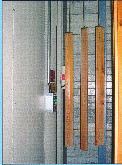
Abb.12 -Lackrocknung mit MOS®
