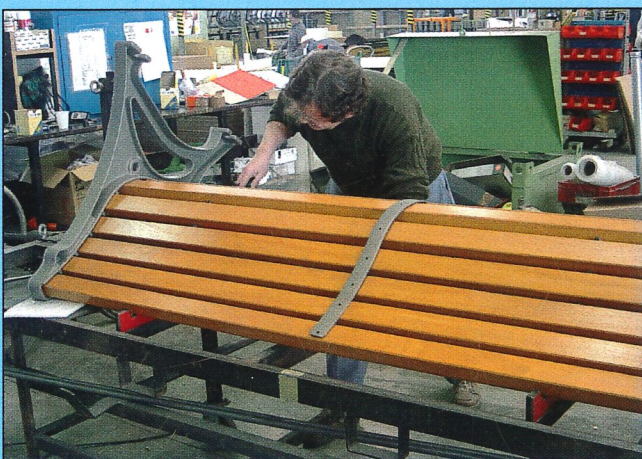
Abb.17 -Montage der Werkstücke
