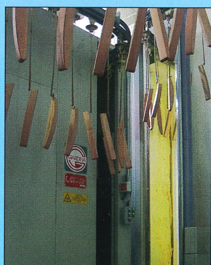
Abb.7 - Imprägnierung Trocknung mit dem MOS® Trockner
