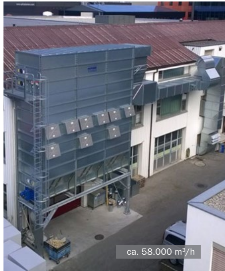
MultiStar Schneckenfilter mit Spülluft • Innenausbau
