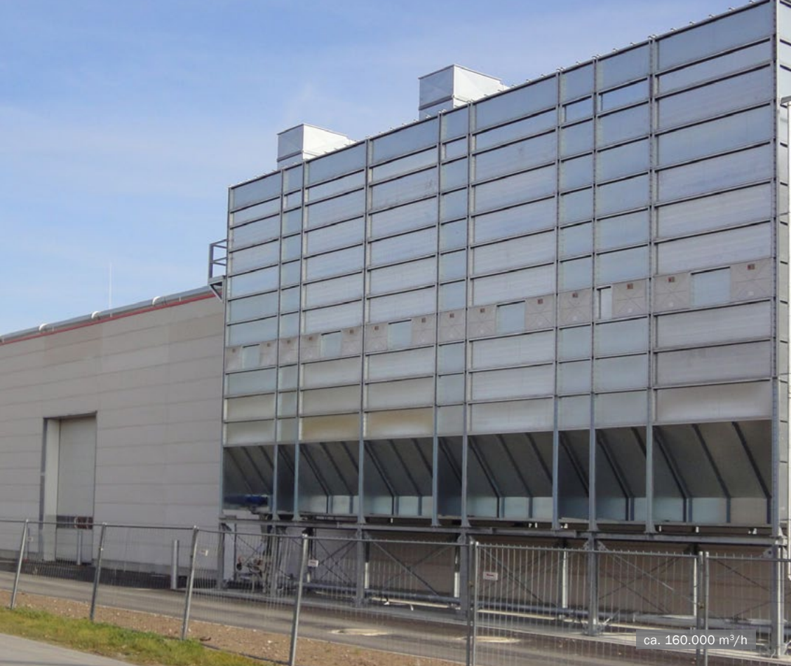
MultiStar Spülluftfilter mit Einblasleerelementen • Möbelfertigung
