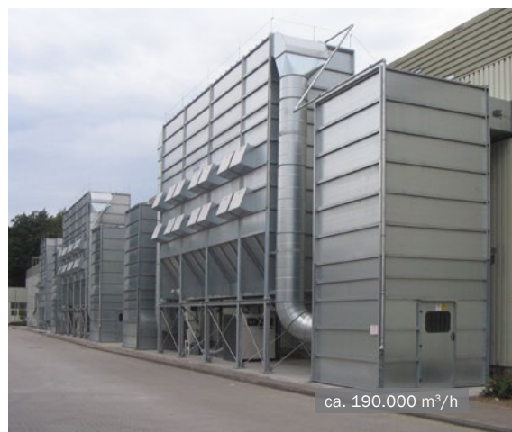
MultiStar Spülluftfilter • Küchenproduktion
