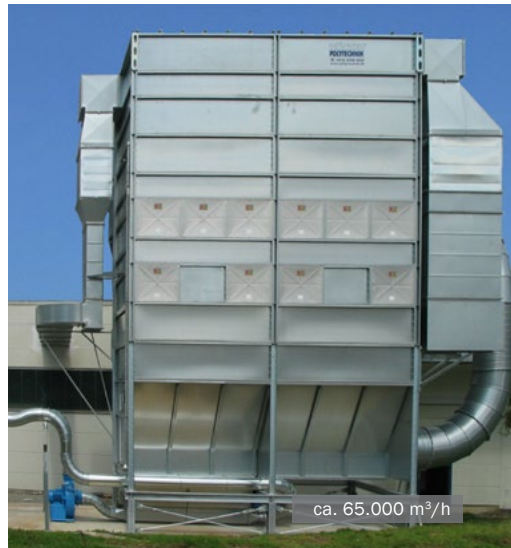
MultiStar Schleusenfilter mit Überbläsung • Möbelzulieferer
