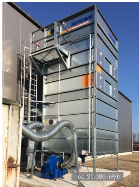
MultiStar Rührwerkaustragefilter • Leimbinderproduktion
