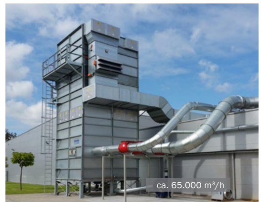
MultiStar Rührfilter • Sperrholzproduktion
