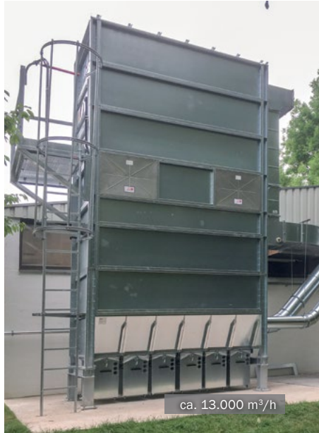
MultiStar Tonnenabsackfilter in der Holzverarbeitung
