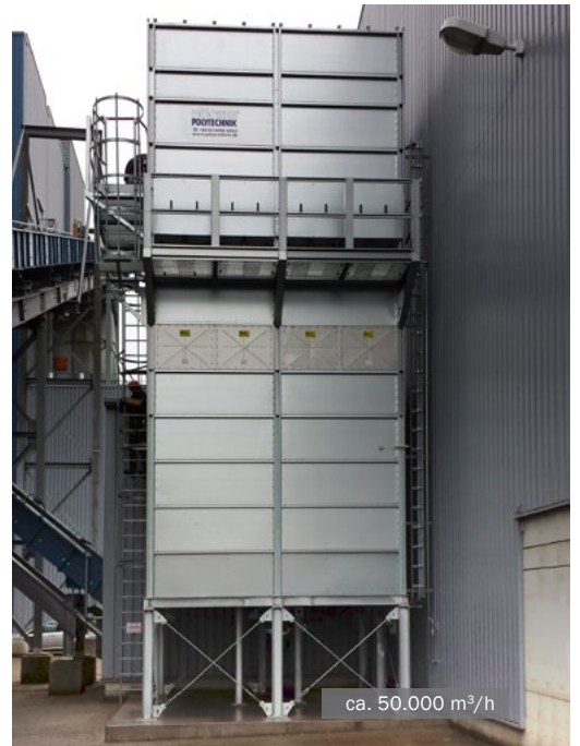
MultiStar Rührwerkfilter • Biomassekraftwerk
