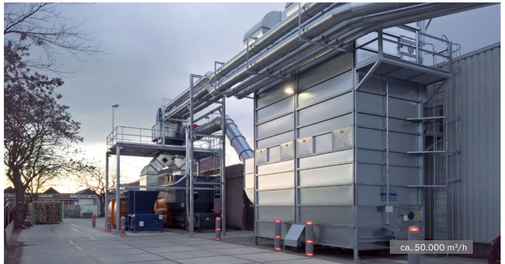
MultiStar Schubbodenfilter mit Jetabreinigung • Druck- und Verpackungsindustrie
