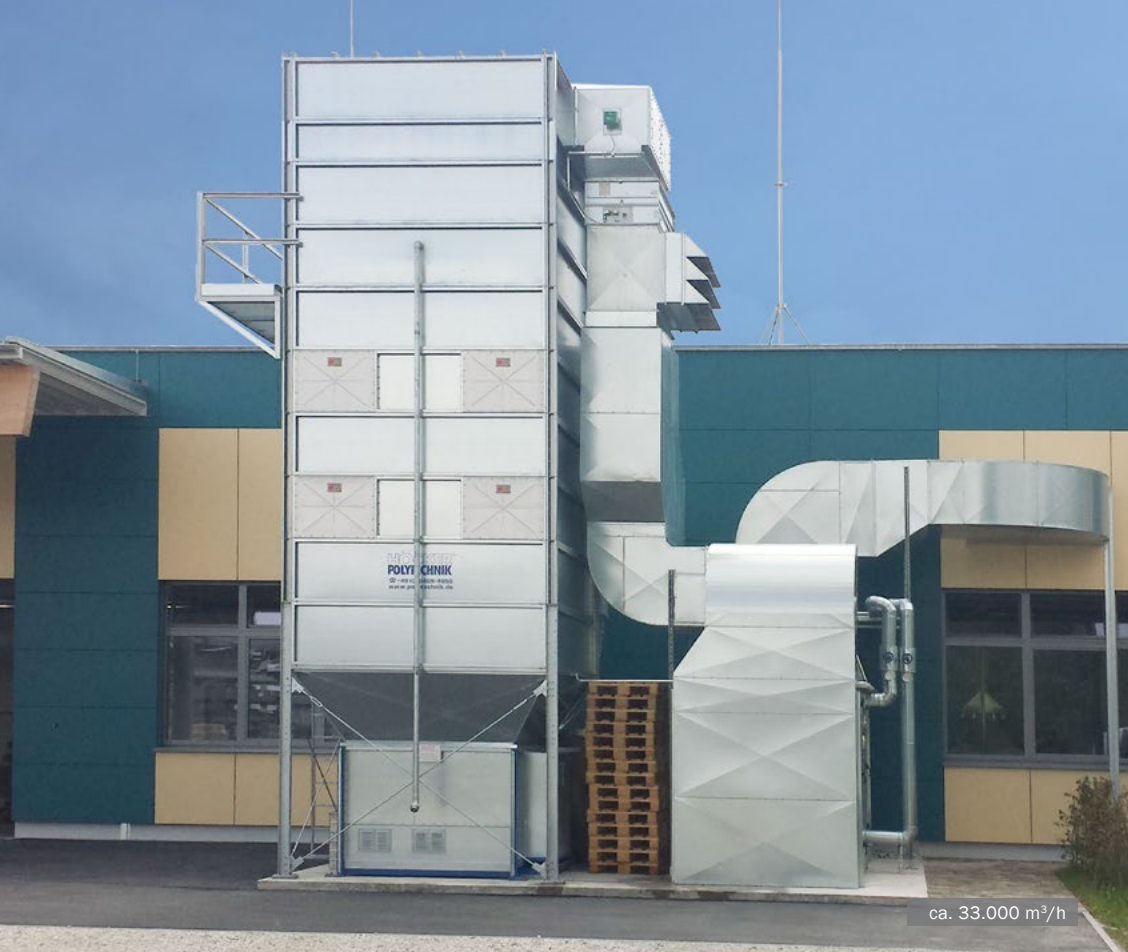
MultiStar Pressenfilter mit Wärmerückgewinnung • Heilpädagogische Einrichtung
