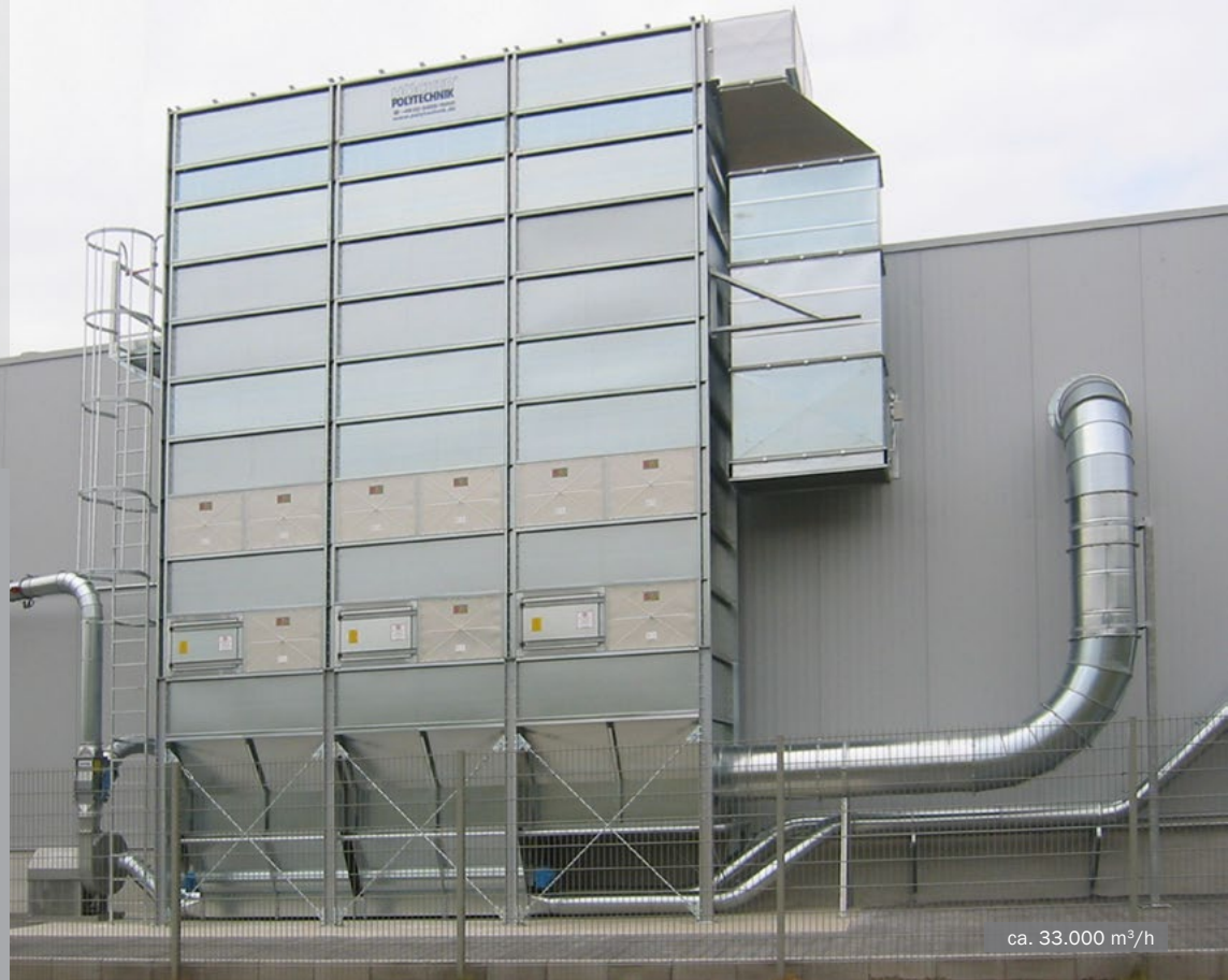
MultiStar Schleusenfilter mit Überbläsung • Möbelfertigung
