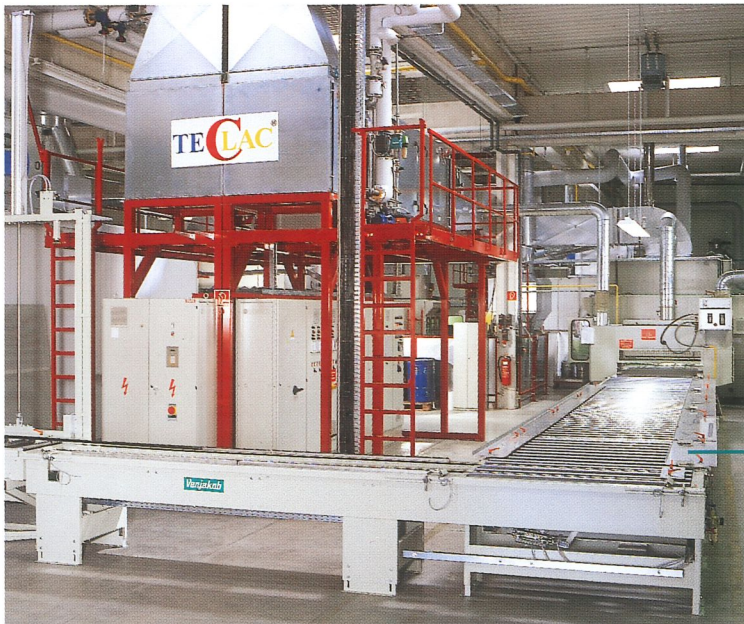
Oberflächenanlage zur Beschichtung von PKW-Kunststoffteilen
