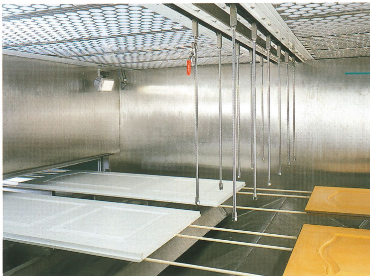
Innenansicht der Anlage mit coolac®-Lackrückgewinnungssystem für wasser verdünnbare Lacke
