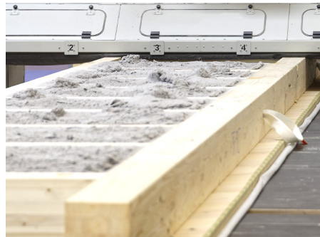
Durchgängige Dokumentation des Dämmvorgang.
