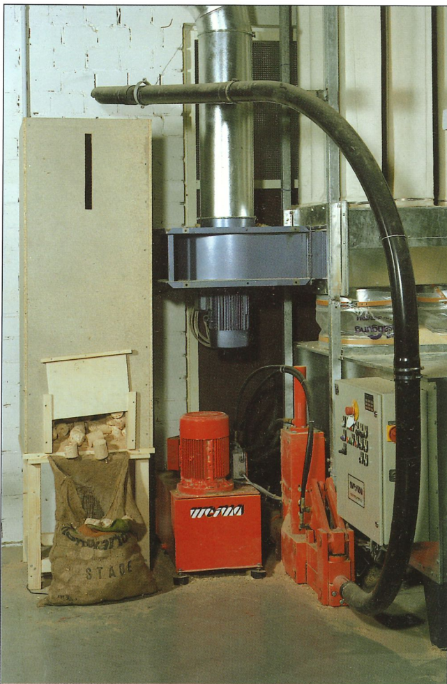
Nachträglicher Einbau unter eine Sackfilteranlage
