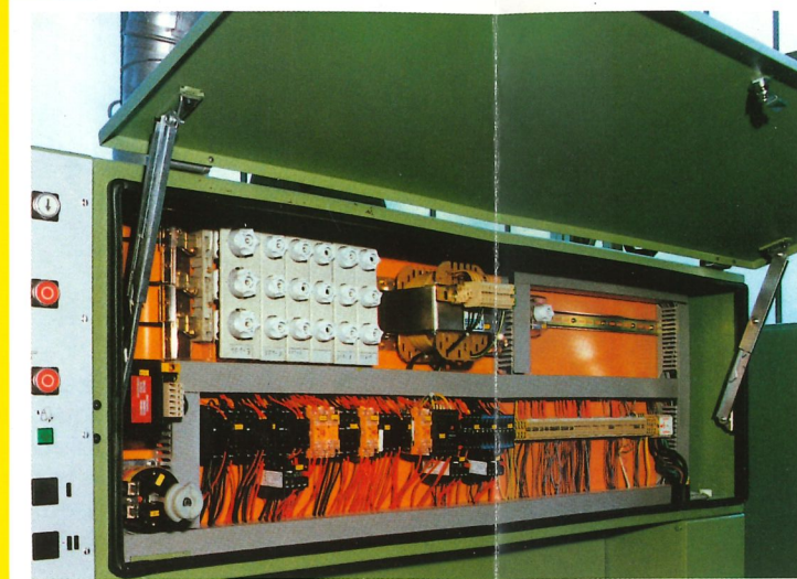
← Elektrische Schalt- und Steuerungselemente – deutsche Markenfabrikate – angeordnet nach VDE-Vorschriften, leichter Zugang durch aufstellbare Haube.
