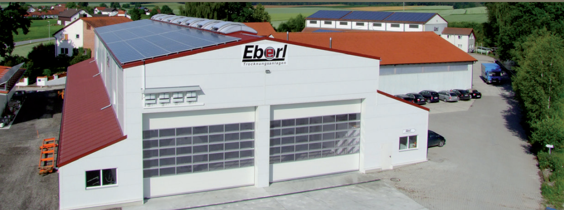
Firmengelände EBERL Trocknungsanlagen in Bodenkirchen (Bayern)
