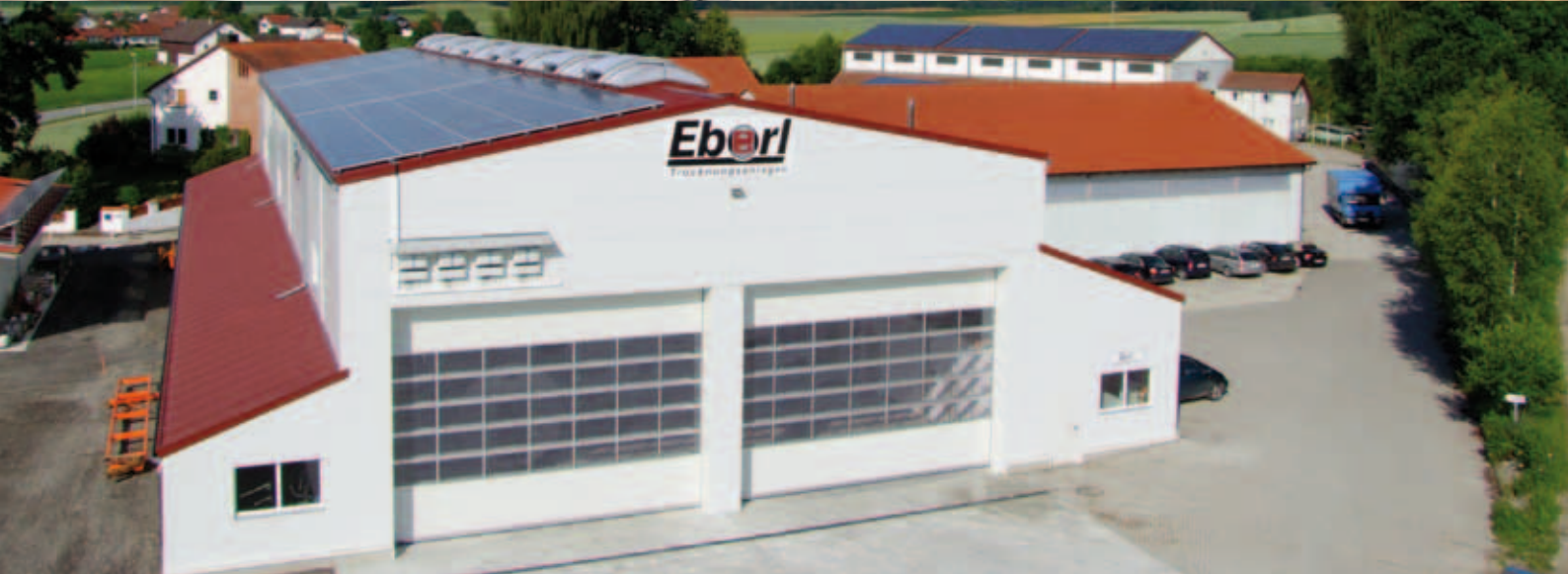
Firmengelände EBERL Trocknungsanlagen in Bodenkirchen (Bayern)
