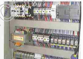
Schaltschrank / SPS-Steuerung
