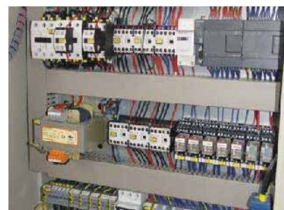
Schaltschrank / SPS-Steuerung
