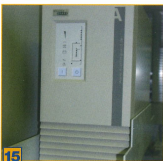
15 Unterbrechungsfreie Stromversorgung (USV) zur Störungsvermeidung bei Netzspannungsschwankungen und Vermeidung von Datenverlusten bei Stromausfall
