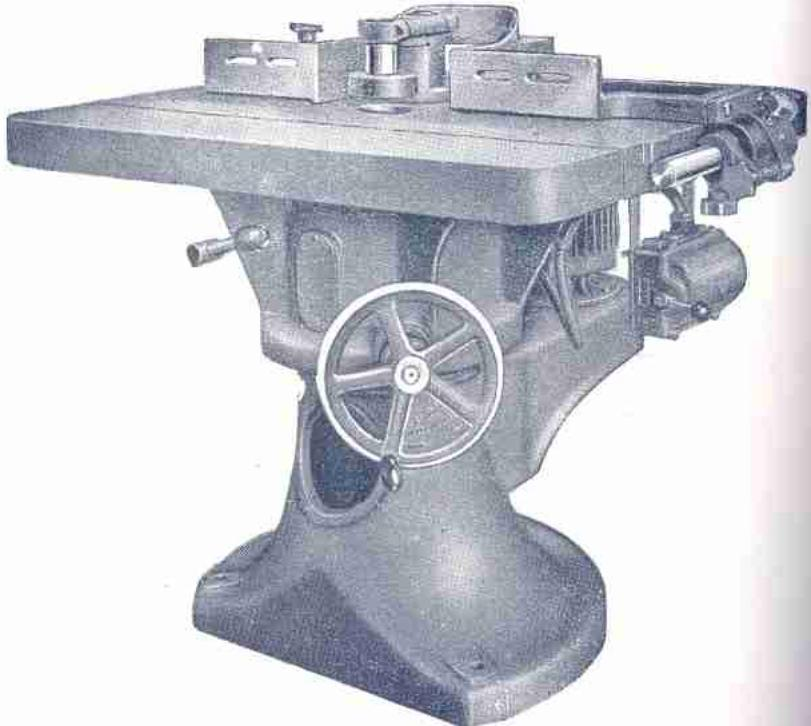
Schwere Starrfräsmaschine mit angebautem, polumschaltbaren Motor Typ SF II
