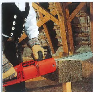
Geringe Lärm- und Geruchsbelastigung in der Altbausanierung am stehenden Objekt.
