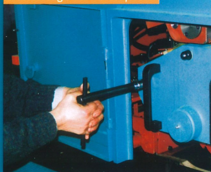
Démontage du contrepalier
