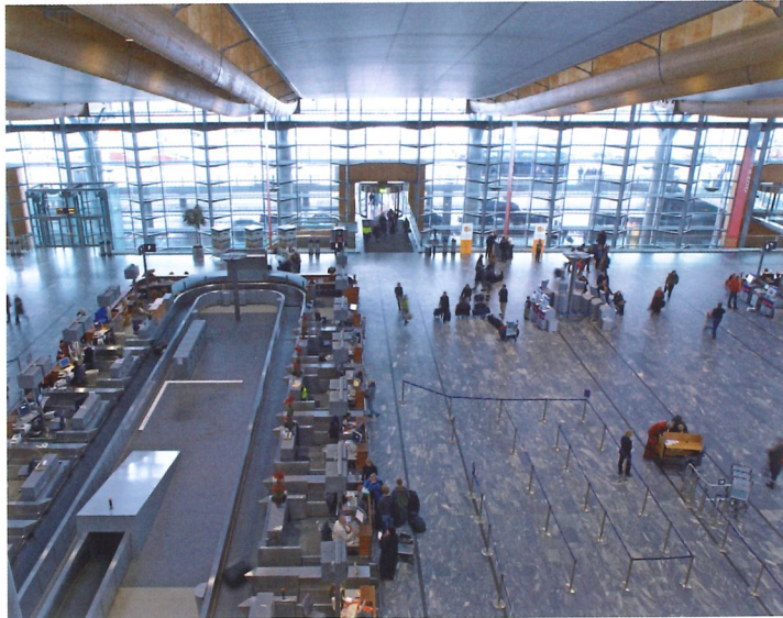
Im Flughafen-Terminal muss für einen reibungslosen Betrieb die Energieversorgung sichergestellt sein.
