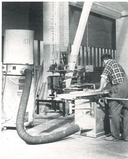
Spänex Mobil eingesetzt zur direkten Maschinenabsaugung. Einsatz überall dort, wo die zentrale Absaugung überlastet bzw. der Aufstellungsort einer Maschine zu weit von der Zentralabsaugung entfernt ist.
