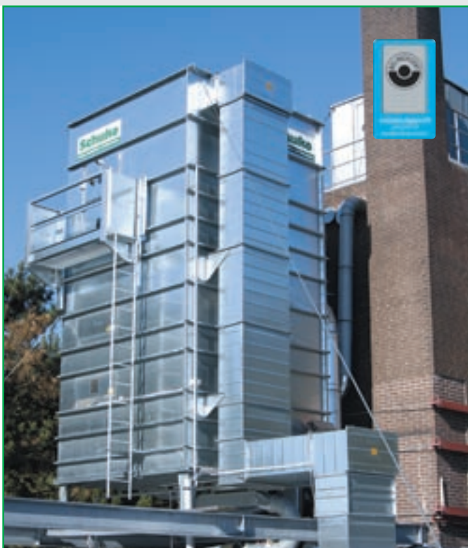
Schuko filtrační jednotka typu Centro 3000
