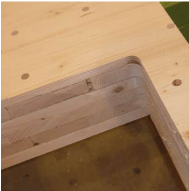
découpe pour fenêtre à la scie et à la fraise à queue
