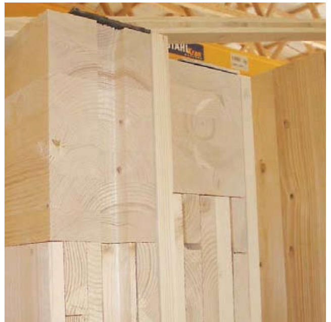
élément avec encastrement et feuillure
