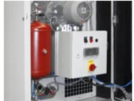
Integrierte Löschautomatik geprüft nach GS-HO-14
