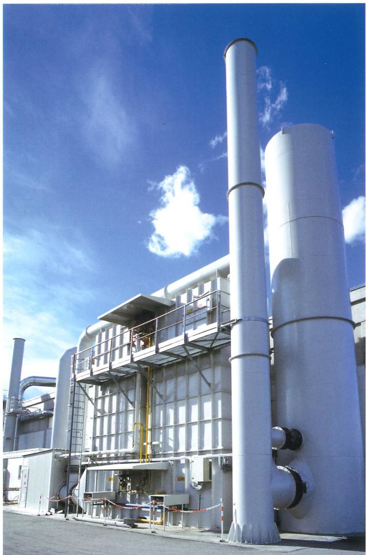
Cefla Finishing mette al servizio dei suoi Clienti che per esigenze produttive utilizzano le vernici a base solvente il suo sistema di depurazione solventi denominato TIF (Combustore Termico ad Inversione di Flusso). Detto impianto si basa su di una esperienza maturata in più di 15 anni di attività nel settore e su decine di installazioni funzionanti in Italia e in Europa.
