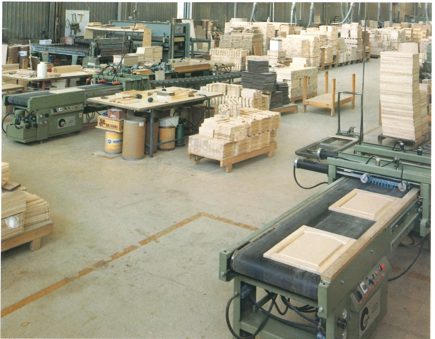
Une usine de portes où travaillent les cadreuses automatiques pour portes et cadres SPN 200.
