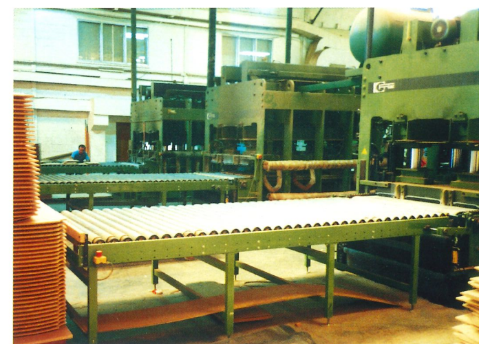
Pressenauslauf mit angetriebenen Auslaufrollbahnen und manueller Stapelung.
