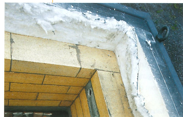
BRENNKAMMERAUFBAU Einzigartige Mehrfachisolierung und hochwertige Schamottierung, gemauertes Gewölbe
