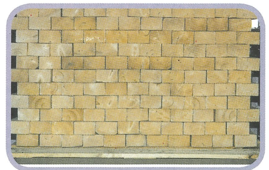
Abb.2: Versetzte Lagen erhöhen die Stabilität
