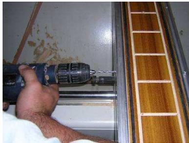
Die Rasterplatten werden in die Profile eingesetzt und seitlich mit Schrauben befestigt.
