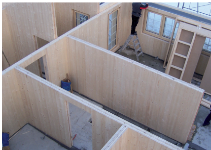
TWOODS-Elemente im Rohbau le gros œuvre avec des éléments TWOODS TWOODS-elements under construction
