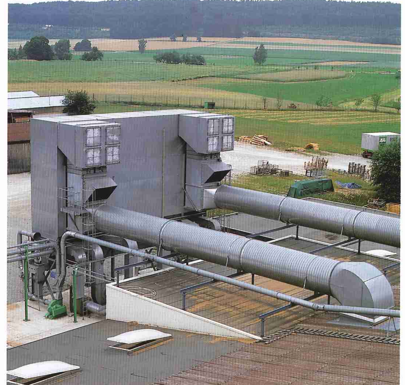
RK-Reihenfilter mit explosionsicherer Lufrückführung in der Holzindustrie
