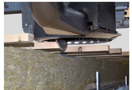
Façonnage des lattes de toit
