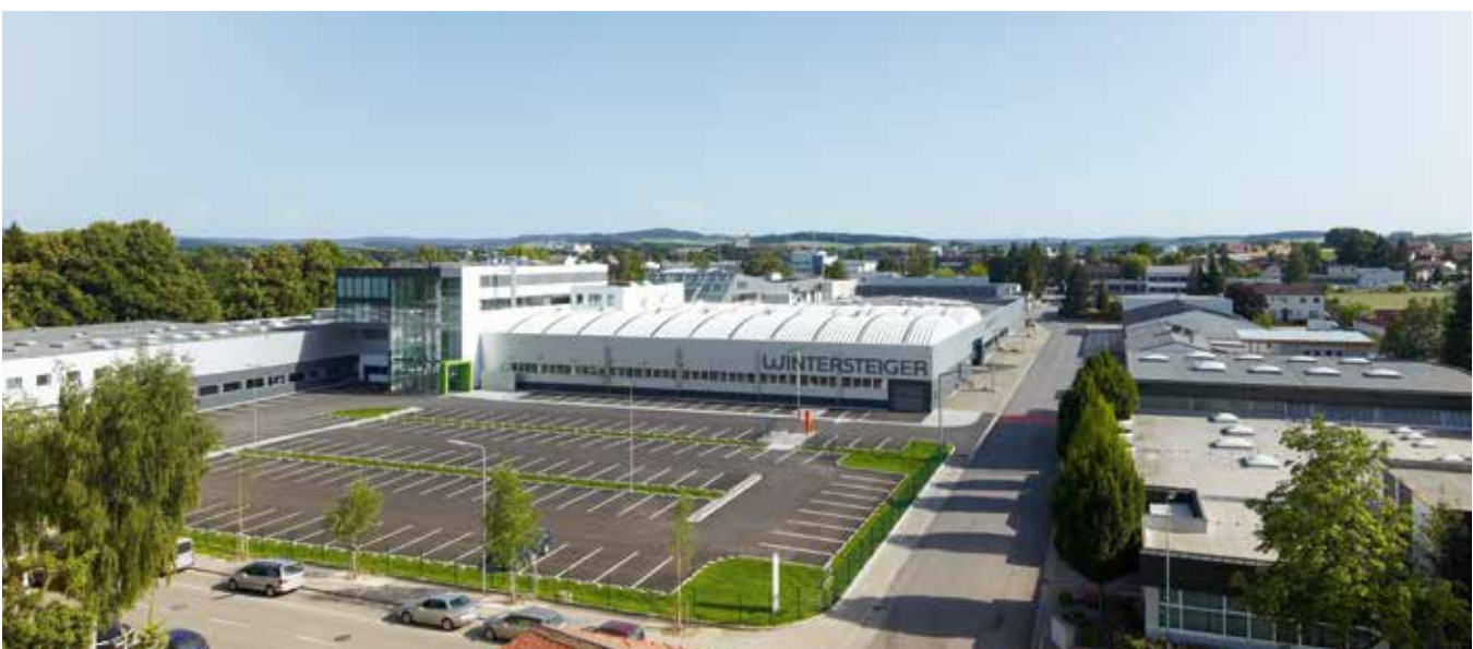
Centrale di Ried in Innkreis, Austria Superiore
