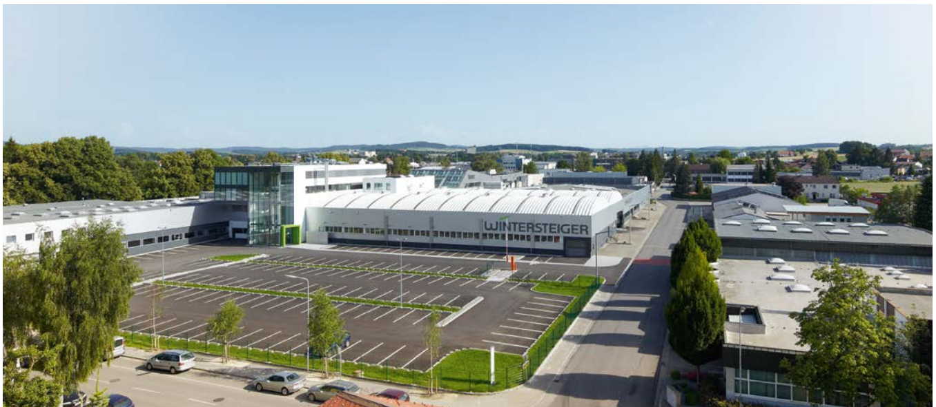
Casa matriz del consorcio en la localidad austriaca de Ried im Innkreis
