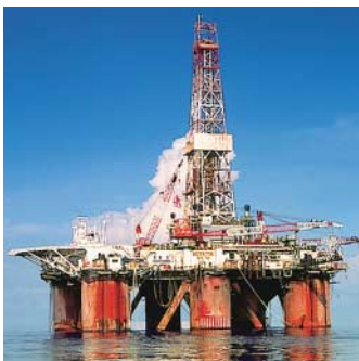
Korrosionsschutz von Offshore-Bauten erfordert robuste Technik.
