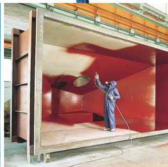
Hohe Leistung plus Handlichkeit wird im Stahlbau gefordert.
