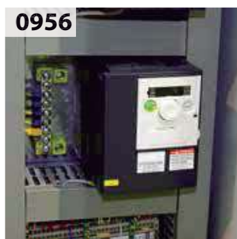
Three-phase inverter/soft 0,75 kw Convertidor/es de frecuencia trifásico/s de 0,75 kw.
