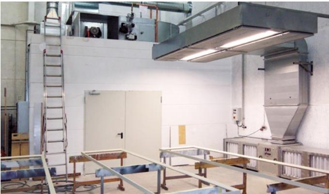
Der Schleifstand bietet ein Höchstmaß an Flexibilität und Arbeitskomfort bei der Absaugung Ihrer Schleifstäube. Durch die gleichmäßige gefilterte Luftzuführung von oben wird eine kontinuierliche Luftströmung zur Absaugung hin gewährleistet.
