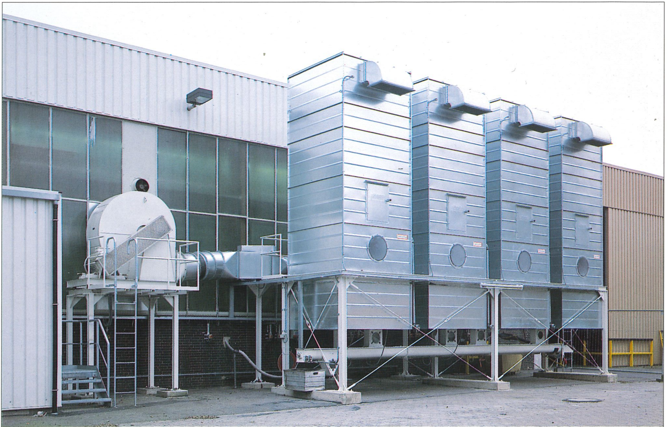
Zwischensilo-Filteranlage zur Einzelaufstellung oder in Reihenaufstellung für kontinuierlichen Betrieb
