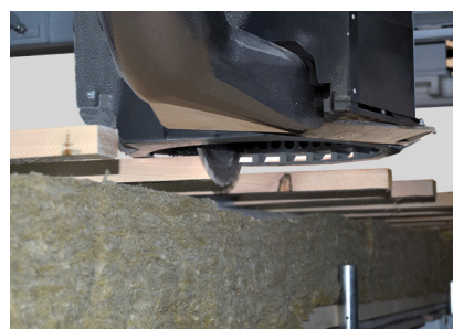
Formatowanie łąt dachowych
