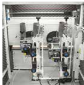
Zona de acabado laminado
