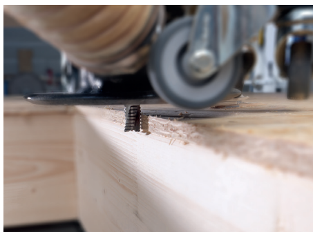
Formatowanie obrzeży zewnętrznych
