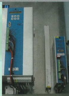
Frequenzumrichter für Schleifband- und Vorschubgeschwindigkeit
