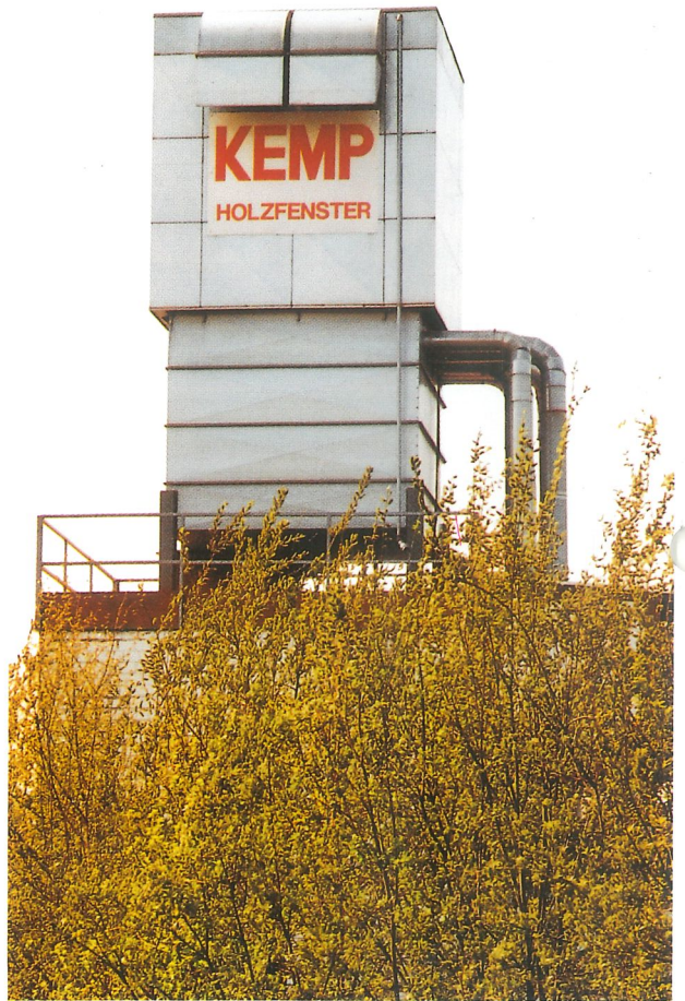
Abbildung zeigt: Filterhaus Type NFHS, mit Zellenradschleuse zur direkten Beschickung vom Spänebunker.
