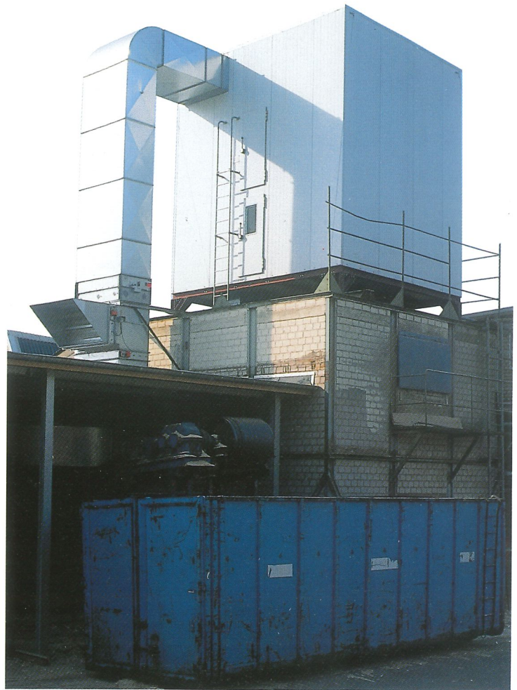
Abbildung zeigt: Nestro Filterhaus mit 80 mm Isolierverkleidung und 633 qm Filterfläche, begehbarem Mittelgang mit Bunkeraustragung und Zellenradschleuse für druckfreie Beschickung des Spänebunkers.
