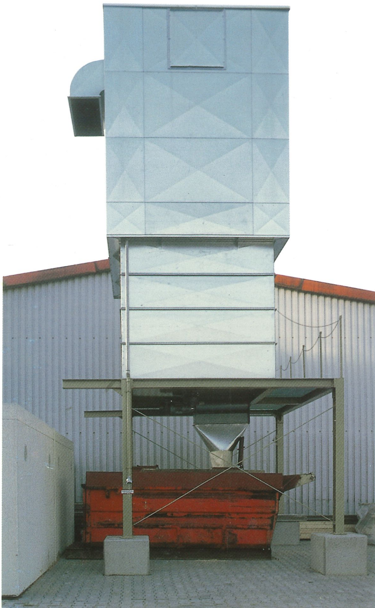
Abbildung zeigt: Filterhaus Type NFHS, 3 x 3 m, mit 261 qm Filterfläche, 4 Stück Aufsatzringe für ca. 10 cbm Späne-Zwischenlager mit Teleskop-Austragungsfräse, Zellenradschleuse, Übergangsstück und Segeltuchstützen, zur staubfreien Container-Beschickung, einschließlich Stahluntergestell.
