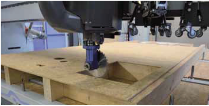
Vollautomatische Bearbeitung der Beplankung | Fully automated processing of the sheathing
