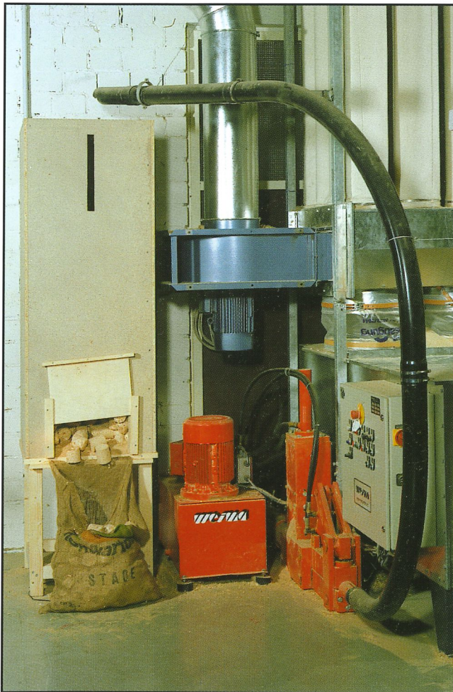
Nachträglicher Einbau unter eine Sackfilteranlage
