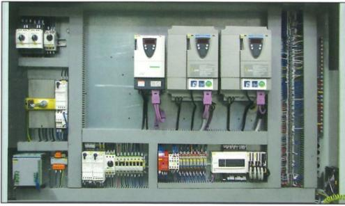
Elektrischer Schaltschrank nach CE-Norm, mit Komponenten führender Hersteller, Aderkodierung, Schaltpläne in der Anleitung oder auf CD hinterlegt.
