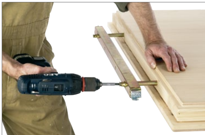
Rüsteisen montieren
