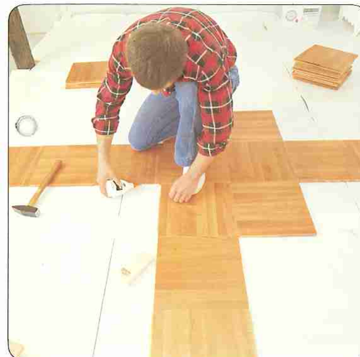
Problemloses Verlegen von Parkettböden. Mit der TGS sind Einpaßarbeiten leicht auszuführen. (11)
