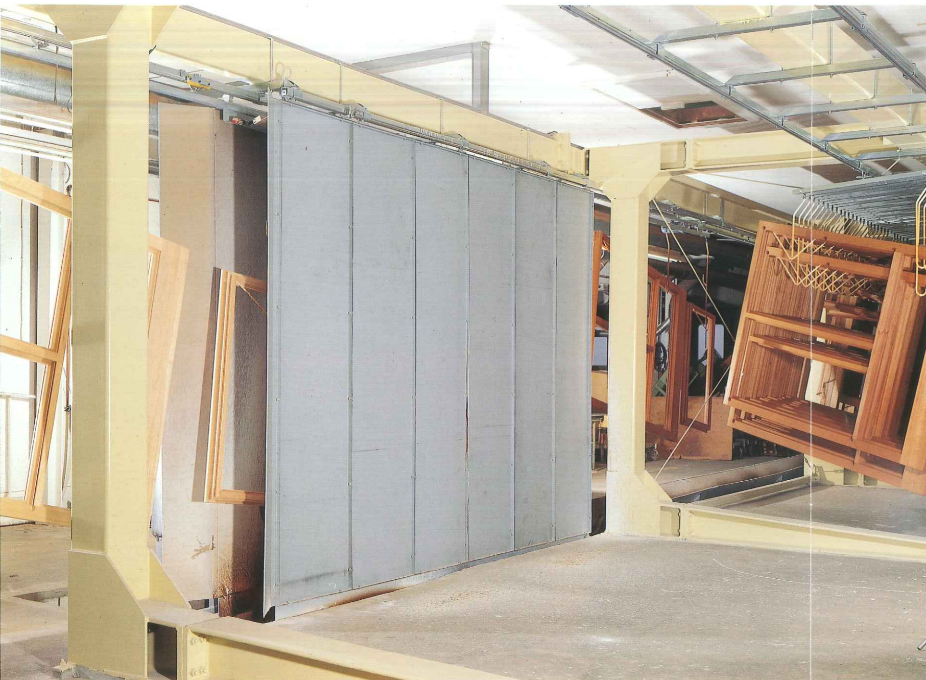
Farbeauftrag durch Sprühdüsen in unserer neuen Rahmengrundieranlage
