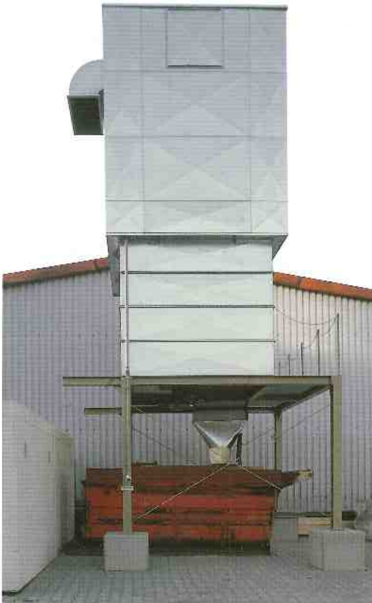
Abbildung zeigt: Filterhaus Type NFHS, 3 x 3 m, mit 261 qm Filterfläche, 4 Stück Aufsatzringe für ca. 10 cbm Späne-Zwischenlager mit Teleskop-Austragungsfräse, Zellenradschleuse, Übergangsstück und Segeltuchstutzen, zur staubfreien Container-Beschickung, einschließlich Stahluntergestell.
