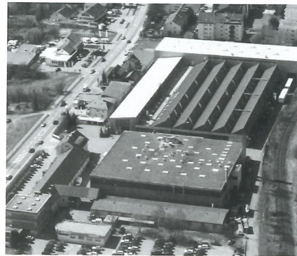
Der Stammsitz unseres 1920 gegründeten Unternehmens liegt im Nordschwarzwald. The headquarters of Robert Bürkle GmbH, founded in 1920, are in the Black Forest region in the South-West of Germany.
