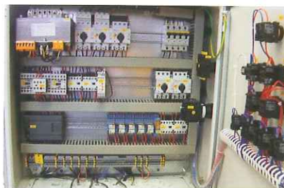
Schaltschrank / SPS-Steuerung
