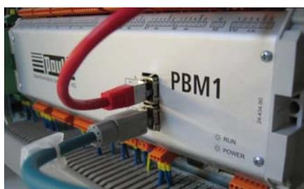
Abb. 5 Verbindung des PAUL Bus-Moduls PBM1 über eine Ethernetleitung
